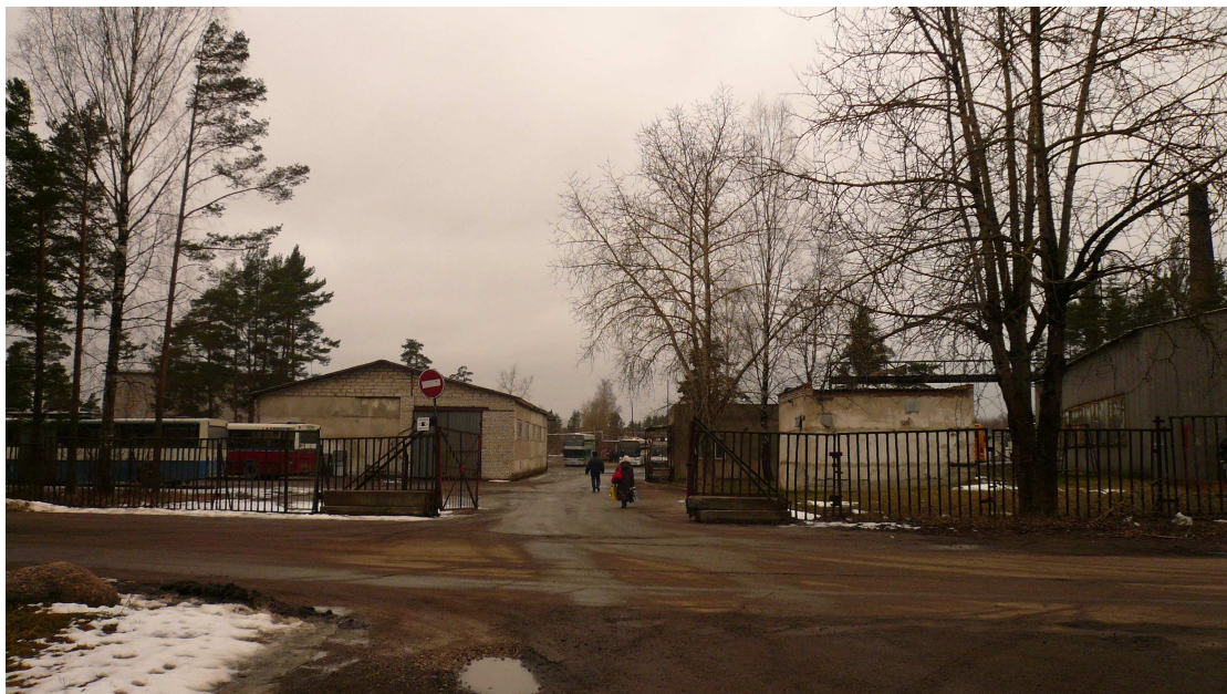
Foto 1. Vaade Kesk tn nurgalt tootmismaale
